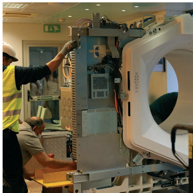
A instalação do novo acelerador linear
